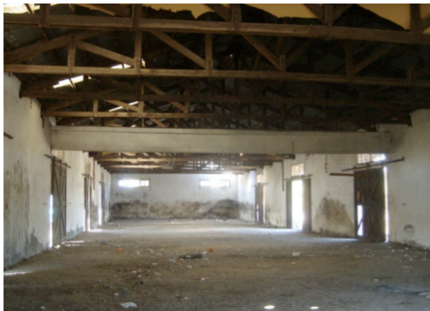
Interior de Bodega de la Estación de Trenes de Teno, 2010
