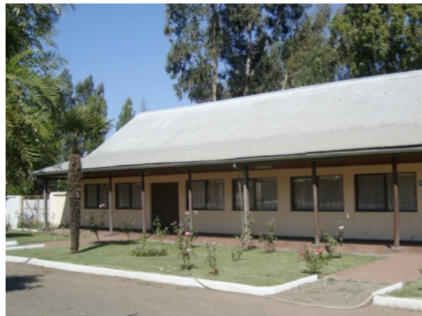
Espacio Multiuso Iglesia de Teno (con daños después del terremoto), 2010
